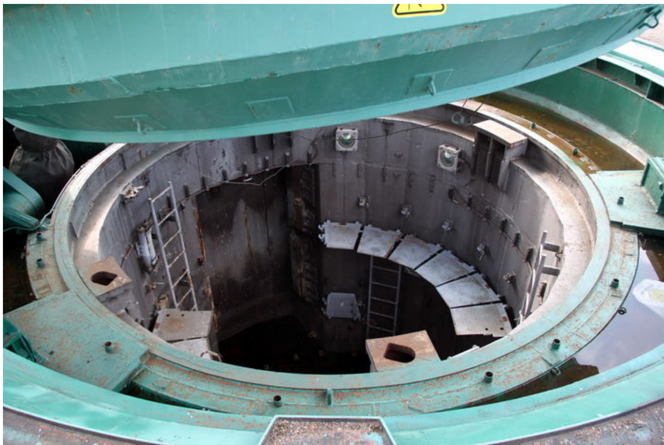
Zalany betonem silos po rakiecie balistycznej RT-23UTTH koło Pierwomajjska na Ukrainie. Fot. Andrzej Hładij/Defence24.pl
